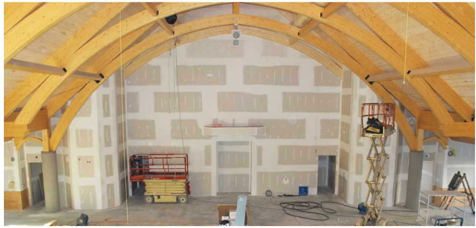
L'arrière de l'église où sera installé l'autel.
